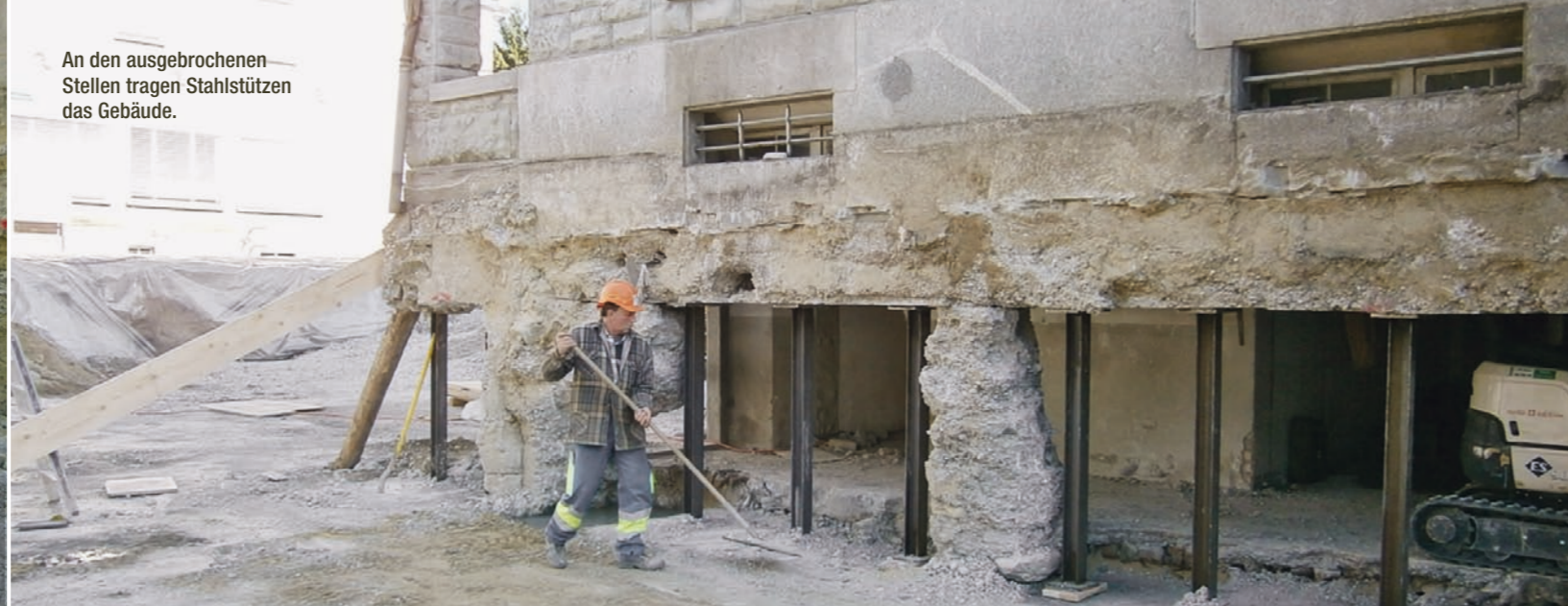
Nachdem die Baugrube rund um den Breitehof ausgehoben war, wurde die Mauer horizontal durchtrennt (rote Markierung) und stellenweise mit dem Ausbruch begonnen.
